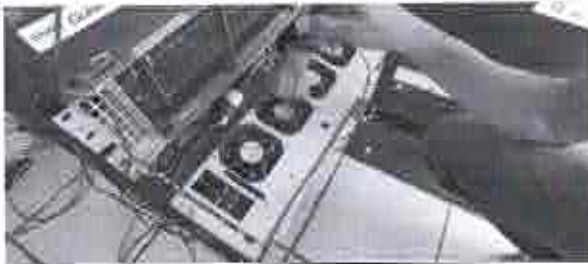
Remoción de polvo acumulado a ventiladores
