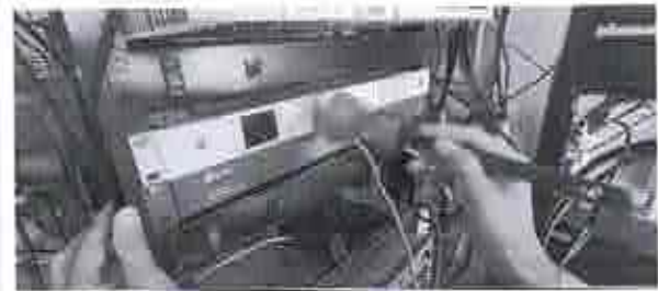
Limpieza a la electrónica de la microonda
