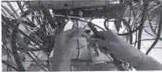
Cambio de conectores en cableado principal
